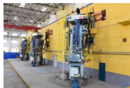
18吨真空自耗炉
